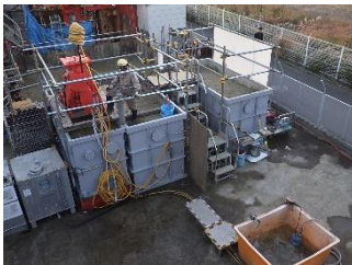
写真 2-1 注入試験状況
