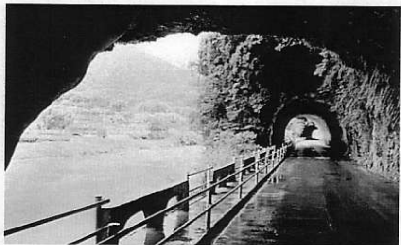
写真1 現在の青の洞門 (1)
