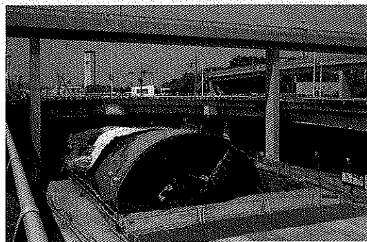
写真-5 シールド地上到達状況
