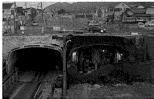
写真-6 道路トンネル（開放型、複合アーチ大断面）での施工事例
