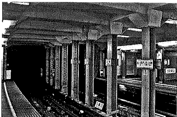
写真-1 鉄構框構造(上野駅)
