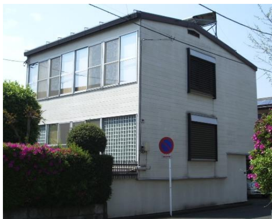
集熱パネル改修後の外観 (2007 年)
