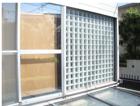
集熱板を取り外して一部をガラスブロックに、 他を断熱戸に改修 (2005 年)
