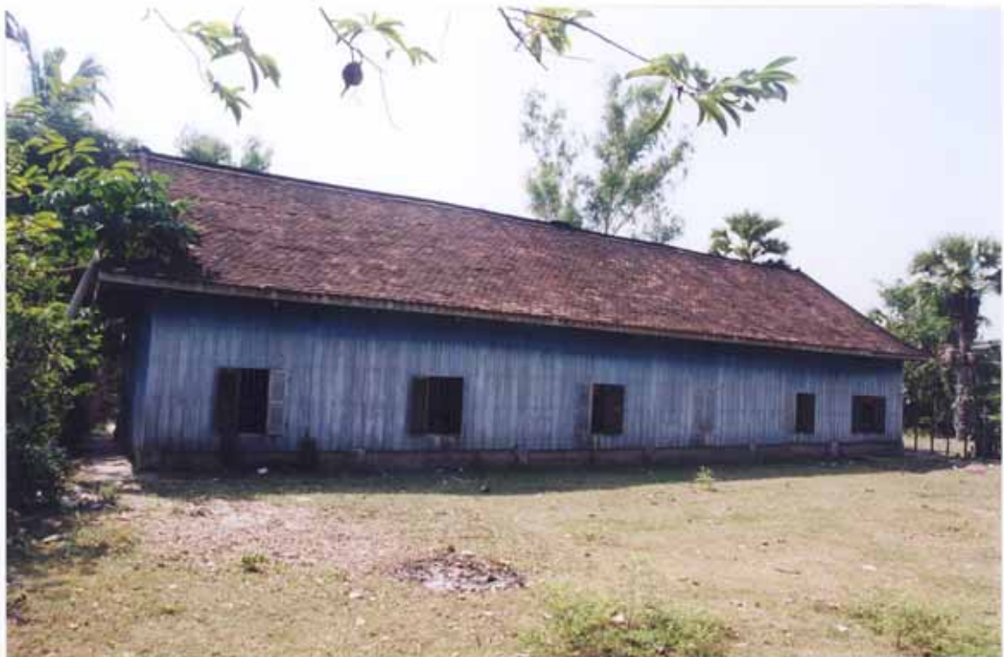
写真4 既存の校舎（背面）
