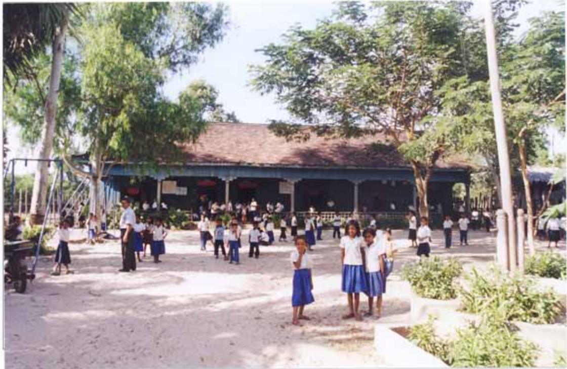
写真3 既存の校舎 1995年に修復したまま老朽化している。
