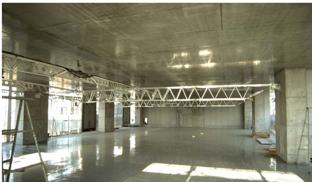
写真 2 SI の実験住宅の躯体。高強度コンクリートを使い、広い空間を確保している。(鉄骨の梁は計測用)
