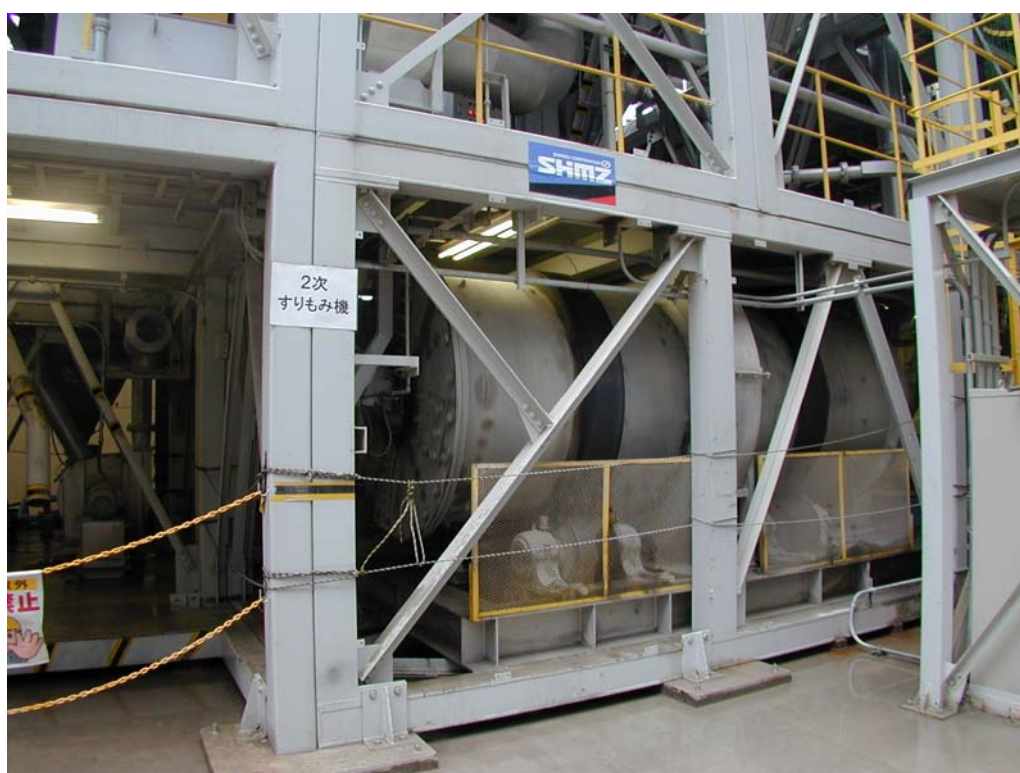
写真 3 解体コンクリートの骨材再生プラントの一部。ドラムの回転でコンクリート片をすり合わせて骨材とセメント分を分離させる。
